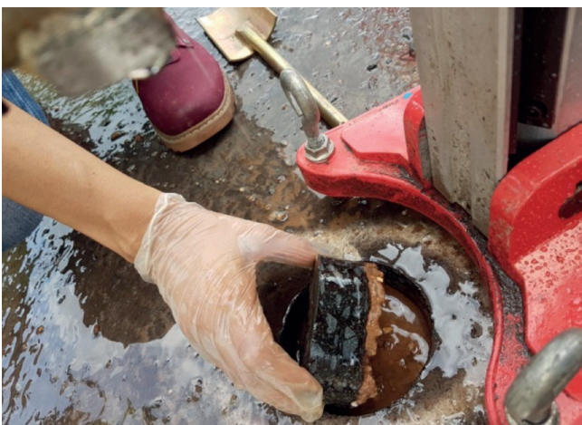
Figura 04 – Preenchimento do local de retirada da amostra e compactação
