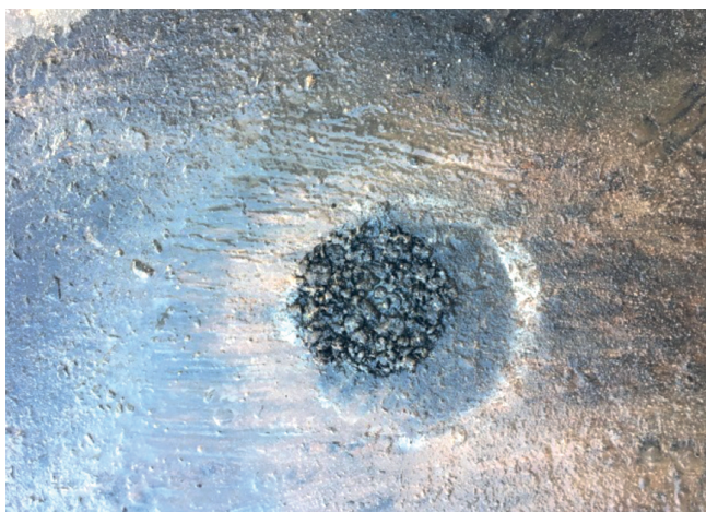
Figura 04 – Preenchimento do local de retirada da amostra e compactação
