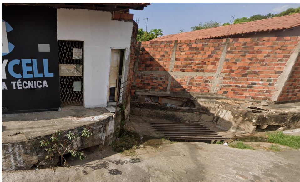
Figura 6 – Exemplo de lote de residências com sistema de drenagem situado sob as casas.
