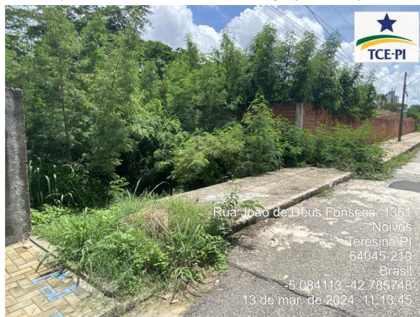
Figura 20: Canal aberto adjacente à via e sem barreira física e com vegetação em avançado estado de crescimento.
