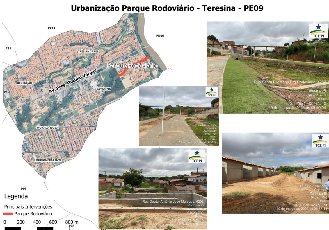
Figura 65 - Intervenção no parque rodoviário
